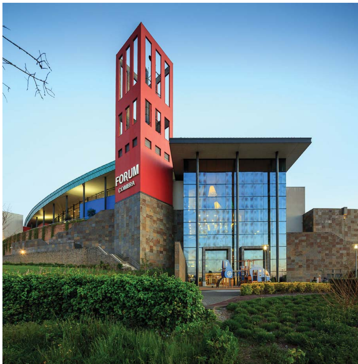
O Forum Coimbra tem actualmente programas em curso para poupar energia e água e instalou uma central de produção de energia fotovoltaica
