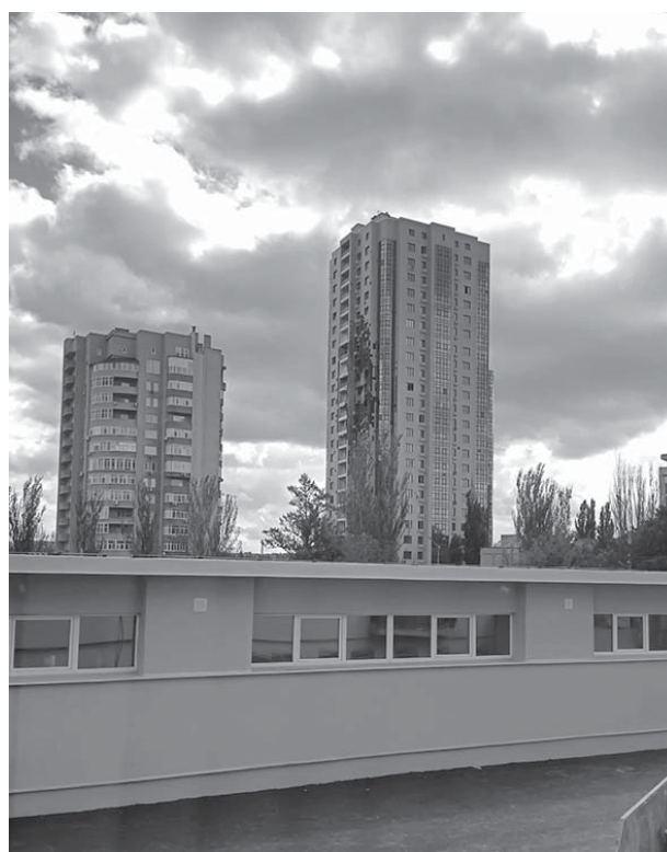
Prédio atingido no centro de Donetsk, cidade onde já há uma escola reconstruída na Rua de Kiev
